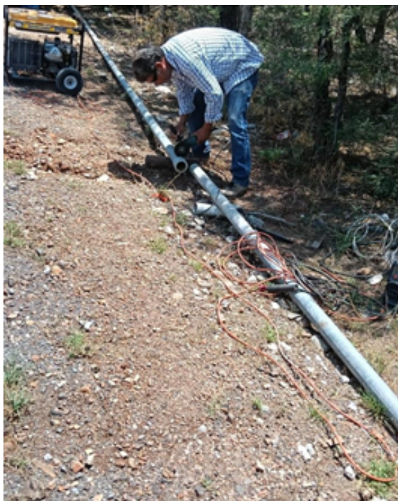
Imagen 3: Reparación de fugas en línea principal del sistema de agua potable de Villa Hidalgo, S.L.P.
